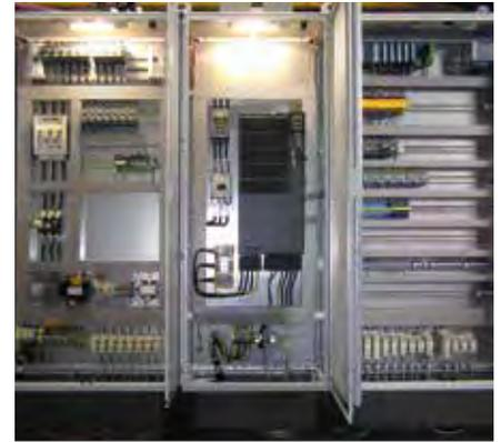
Fertigung einer komplett neuen Siemenssteuerung S7-300 einschließlich Softwareerstellung durch unsere Ingenieure.
